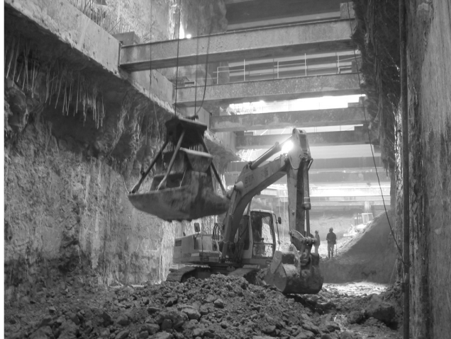
Figura 6 – Zona A. Escavação dentro da estação. Paredes moldadas e Escoramentos
