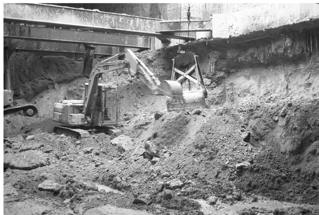
Figura 8 – Escavação da zona do eixo 4 a 21, abaixo dos escoramentos metálicos.
